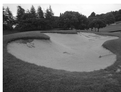
キャピラリーコンクリート導入バンカー
